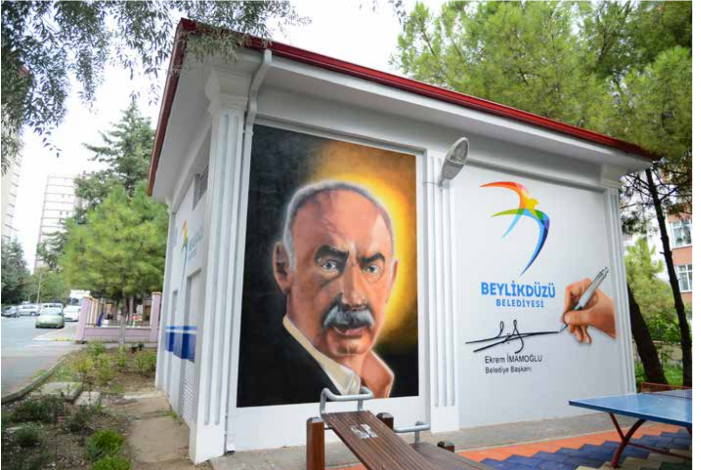
Şener Şen Parkı trafo süsleme
